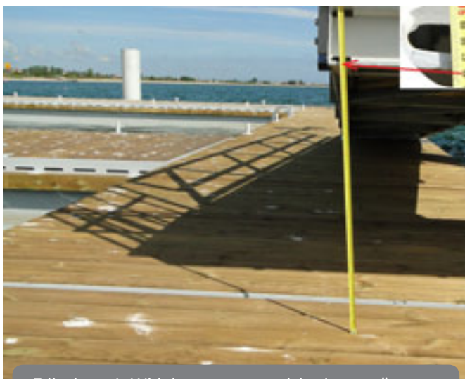
Zdjęcie nr 1. Widok pontonu „podchodzącego” pod zejście z pomostu
