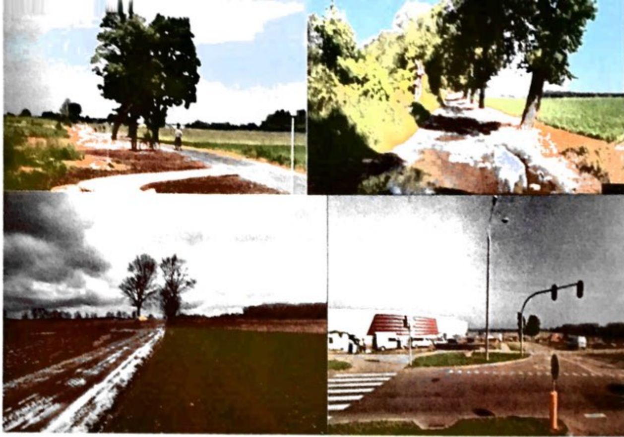
Rys. nr 1. Stan istniejący ul. Derdowskiego
