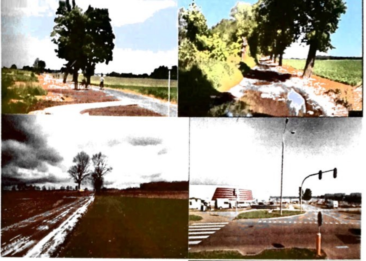
Rys. nr 1. Stan istniejący ul. Derdowskiego
